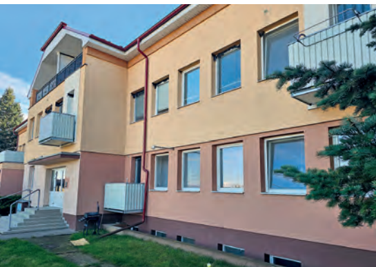
Bývalú administratívnu budovu družstvo prerobilo na bytovku pre zamestnancov.
